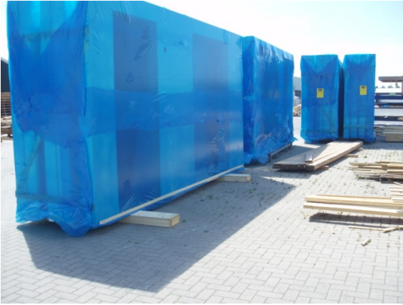
Figur 5 Väggelement färdiga för leverans Bild: Anders Gustafsson
